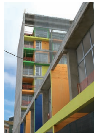
Edificio de 127 viviendas de promoción pública ubicado en Monte Hacho (Ceuta). | fotos: mvtv
